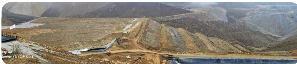
شکل ۱- نمای از هیپ معدن مس سونگون حین بارگذاری لایه اول
